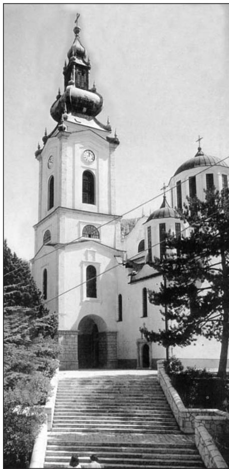
Изглед Мостарске цркве пре рушења
